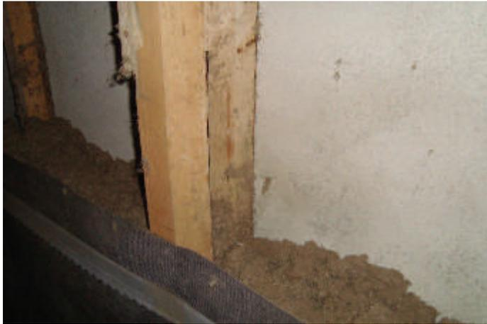
Abb. 3-5 Hinterfüllung mit Flachsflor
